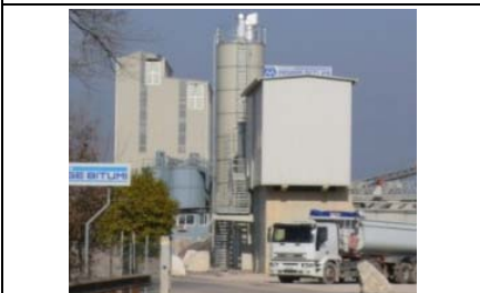
Attività lavorazione ghiaia
